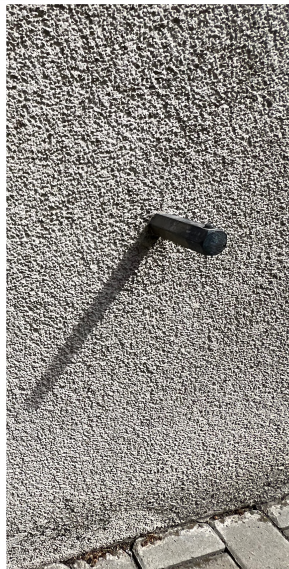
reper ścienny na budynku budownictwa A2 (BL)
